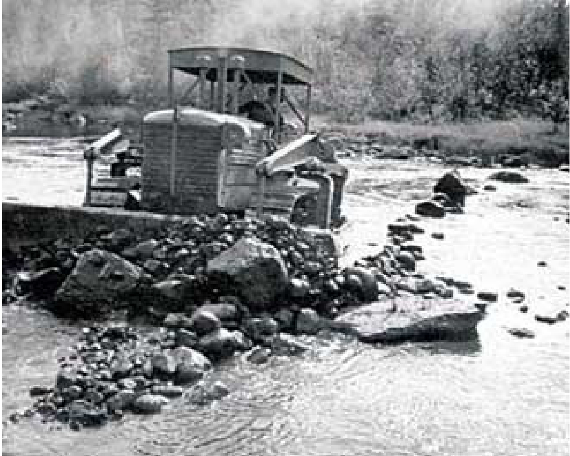
Flottledsrensning med bandtraktor i Vormbäcken, biflöde till Vindelälven. Källa: Umeå flottningsförenings arkiv, Folk-rörelsearkivet, Umeå.
