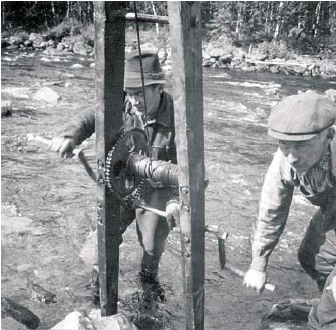
Rensning för hand med stubbrytare. Källa: Umeå flottningsförenings arkiv, Folkrörelsearkivet, Umeå.
